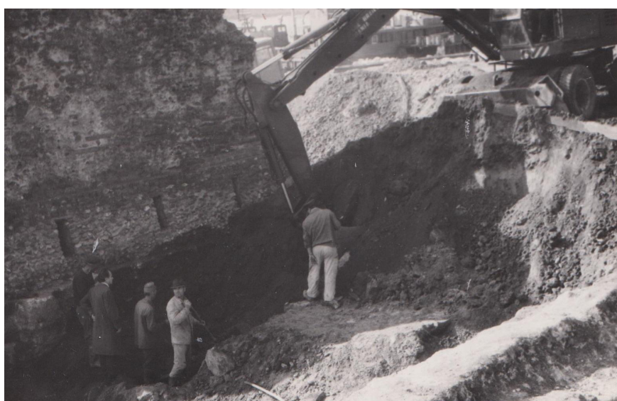
Pl. X. 1. Foto lucrări mecanizate pe latura estică a pilei culee, 14.09.1984, fond nr. 854, inv. nr. 954, SJAN MH, dosar 11/1983-1984. 2. Foto lucrări mecanizate pentru dezafectarea vechii căi ferate situată între pila B2 și pila C, 14.09.1984, fond nr. 854, inv. nr. 954, SJAN MH, dosar 11/1983-1984. 3. Foto lucrări mecanizate pe latura nordică a pilei culee, 14.09.1984, fond nr. 854, inv. nr. 954, SJAN MH, dosar 11/1983-1984.
