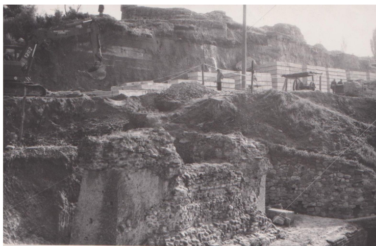
Pl. VI. 1-5. Foto lucrări între pila intermediară B și pila portal (pila A), tăiere cu cablu a părții vestice a fundației pilei A – 16.05.1984, fond nr. 854, inv. nr. 954, SJAN MH, dosar 11/1983-1984. 6. Foto lucrări mecanizate la nord de pila portal (pila A) pentru translatarea căii ferate, amenajare perete de sprijin pe latura sudică a castrului roman – 16.05.1984, fond nr. 854, inv. nr. 954, SJAN MH, dosar 11/1983-1984.
