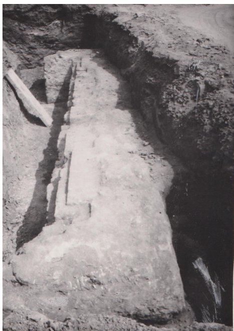
Pl. VIII. 1, 2, 4. Foto radier turnat în zona pilei B, 03, 28.08.1984, fond nr. 854, inv. nr. 954, SJAN MH, dosar 11/1983-1984. 3. Foto decopertare pila intermediară B2, 28.08.1984, fond nr. 854, inv. nr. 954, SJAN MH, dosar 11/1983-1984.
