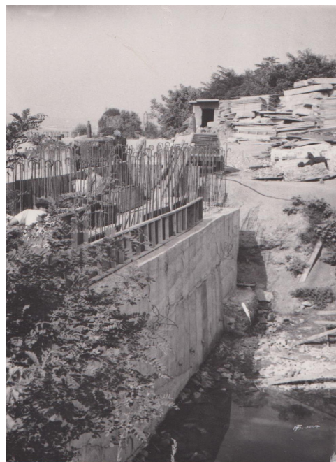
Pl. VIII. 1, 2, 4. Foto radier turnat în zona pilei B, 03, 28.08.1984, fond nr. 854, inv. nr. 954, SJAN MH, dosar 11/1983-1984. 3. Foto decopertare pila intermediară B2, 28.08.1984, fond nr. 854, inv. nr. 954, SJAN MH, dosar 11/1983-1984.
